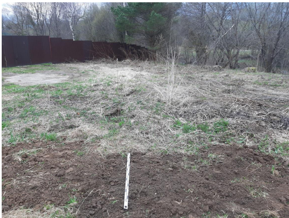
Рис. 55. Участок проведения археологических исследований на объекте «Уличные газопроводы д. Городня Боровского района». Засыпанный шурф 5. Вид с севера.
