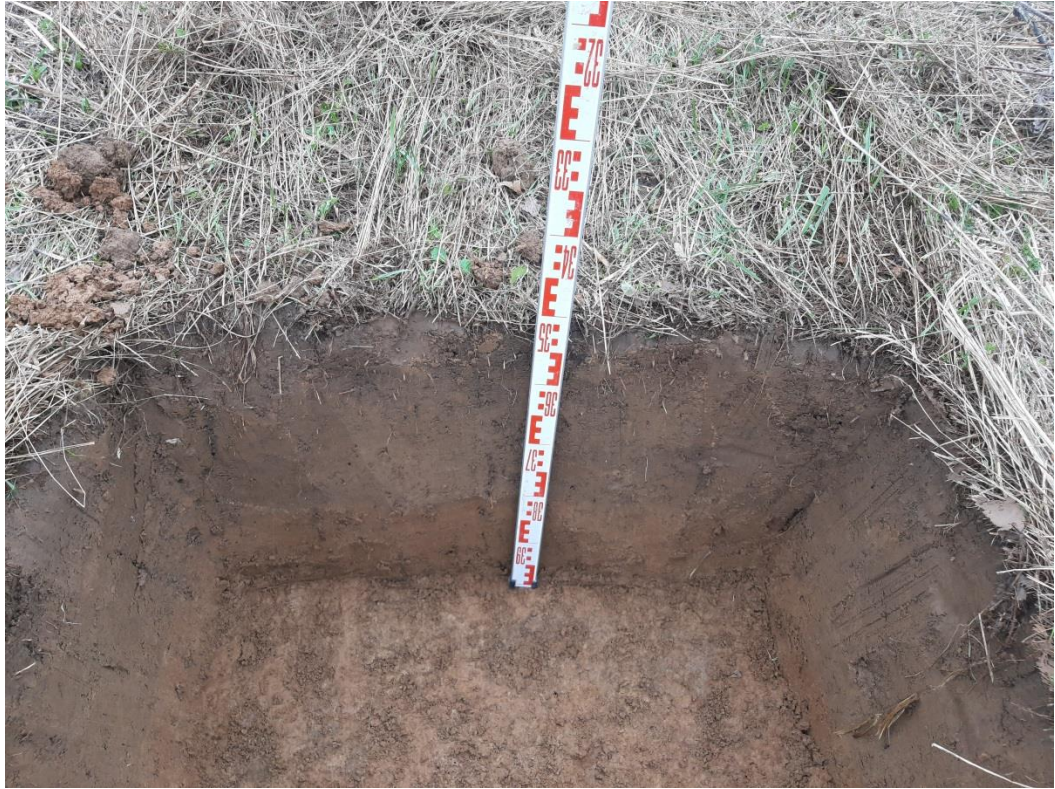
Рис. 30. Участок проведения археологических исследований на объекте «Уличные газопроводы д. Городня Боровского района». Шурф 1. Вид с севера.
